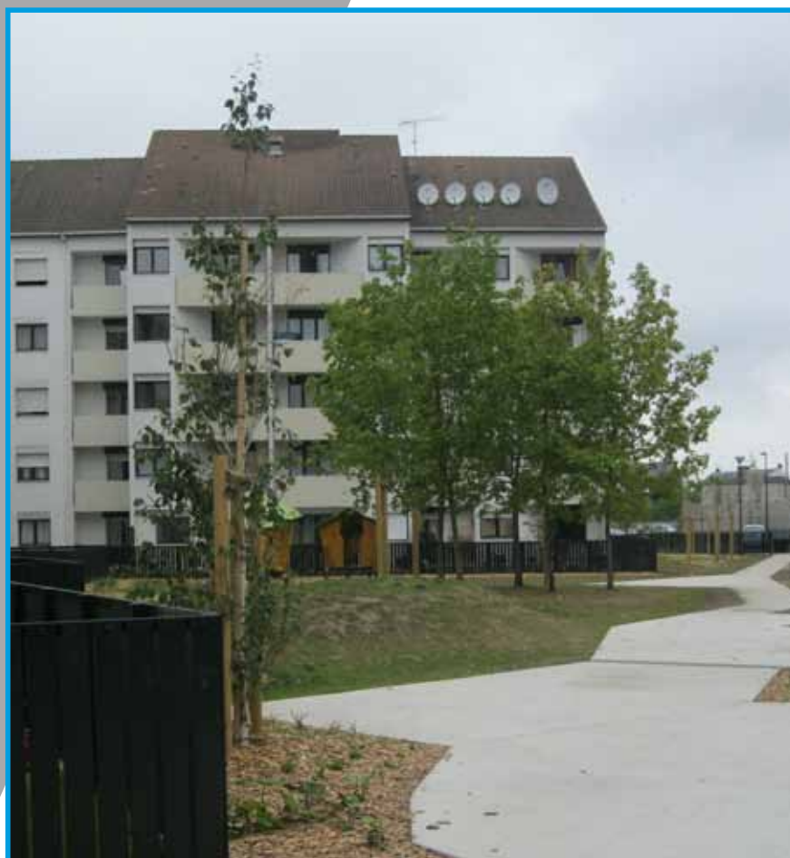
La raquette après les travaux
