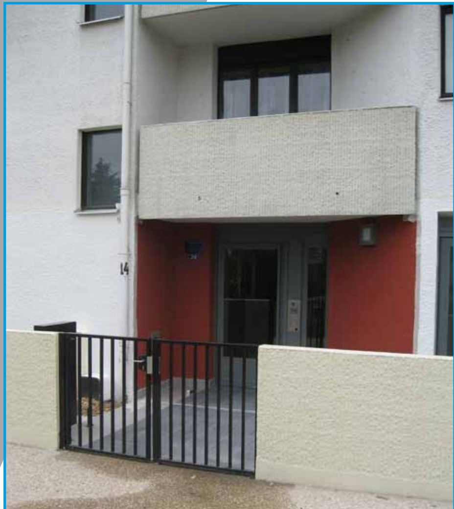
Le hall après les travaux
