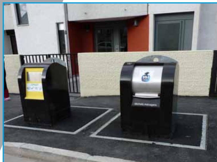
Installation des colonnes enterrées.
