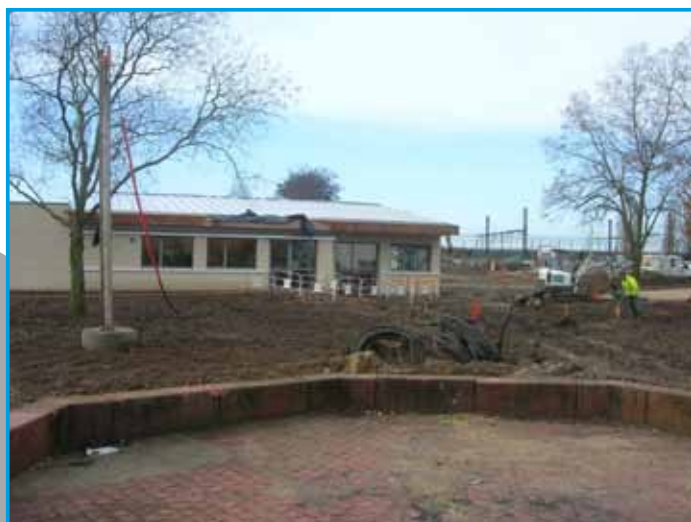
Chantier de la maison pour tous
