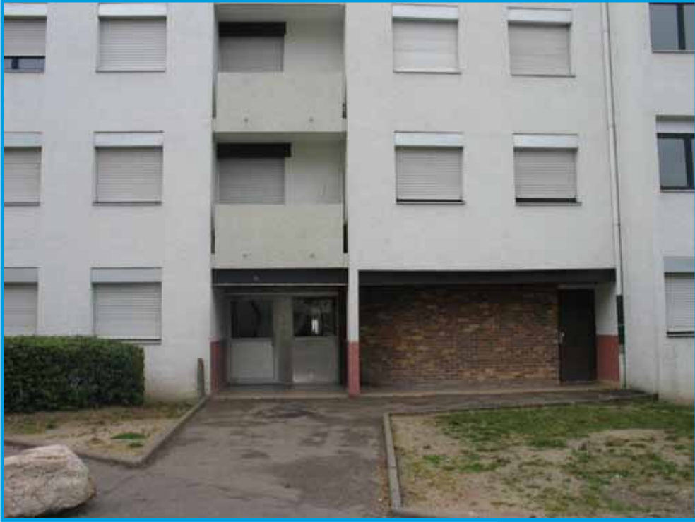
Le hall avant les travaux
