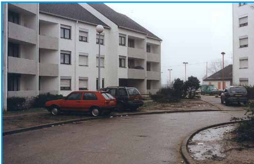
La raquette avant les travaux
